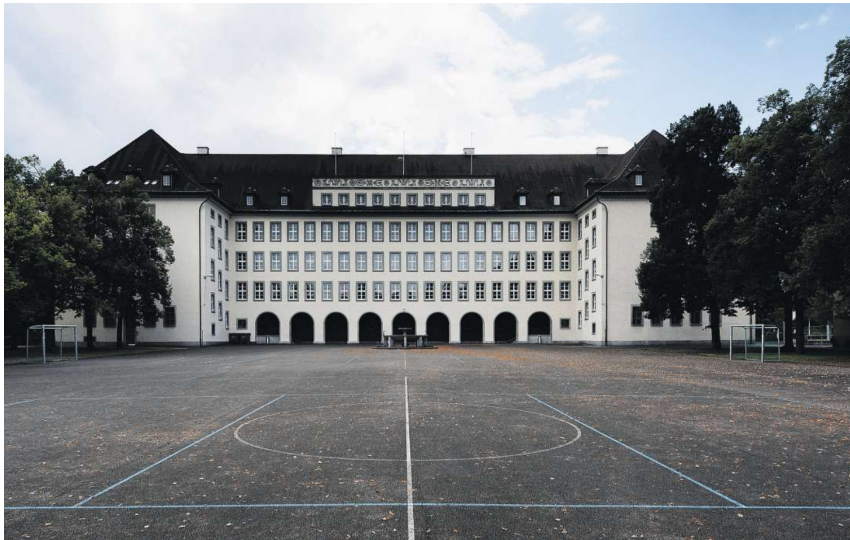
Bemerkenswerte Schulhäuser in Zürich: Elemente des Neoklassizismus, des Art déco und der moderaten Moderne wussten Albert Maurer und Hans Vogelsanger beim 1924 vollendeten Oberstufenschulhaus Liguster in Oerlikon zu einem monumentalen, streng axialsymmetrischen Gebäude von palastartiger Ausstrahlung zu vereinen. ANNICK RAMP / NZZ
